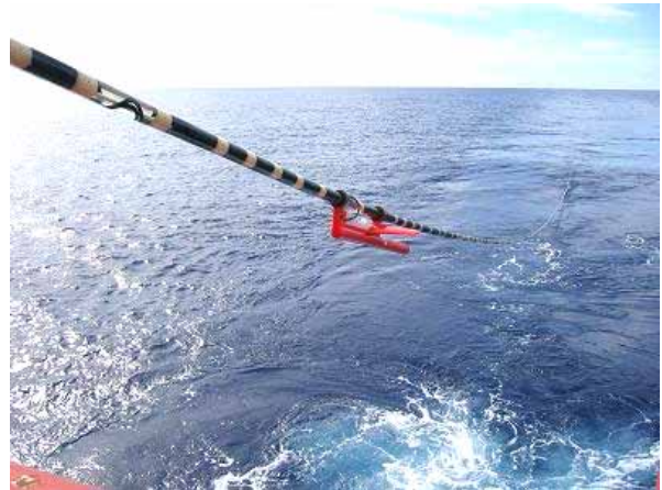
写真-15 ケーブル投入作業
